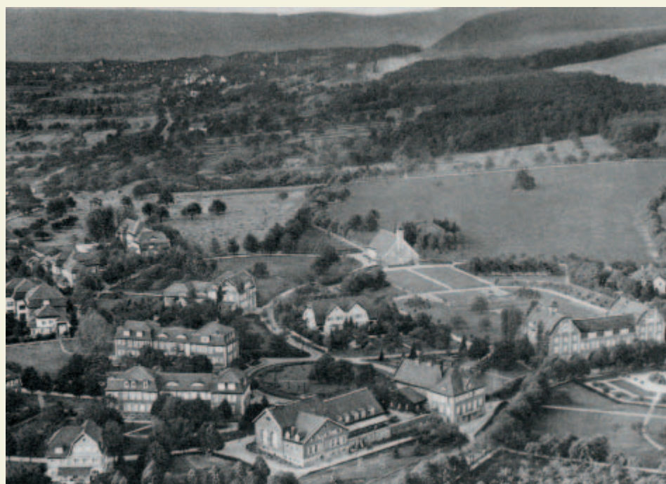
1929 - Luftaufnahme der Heil- und Pflegeanstalt Wiesloch
