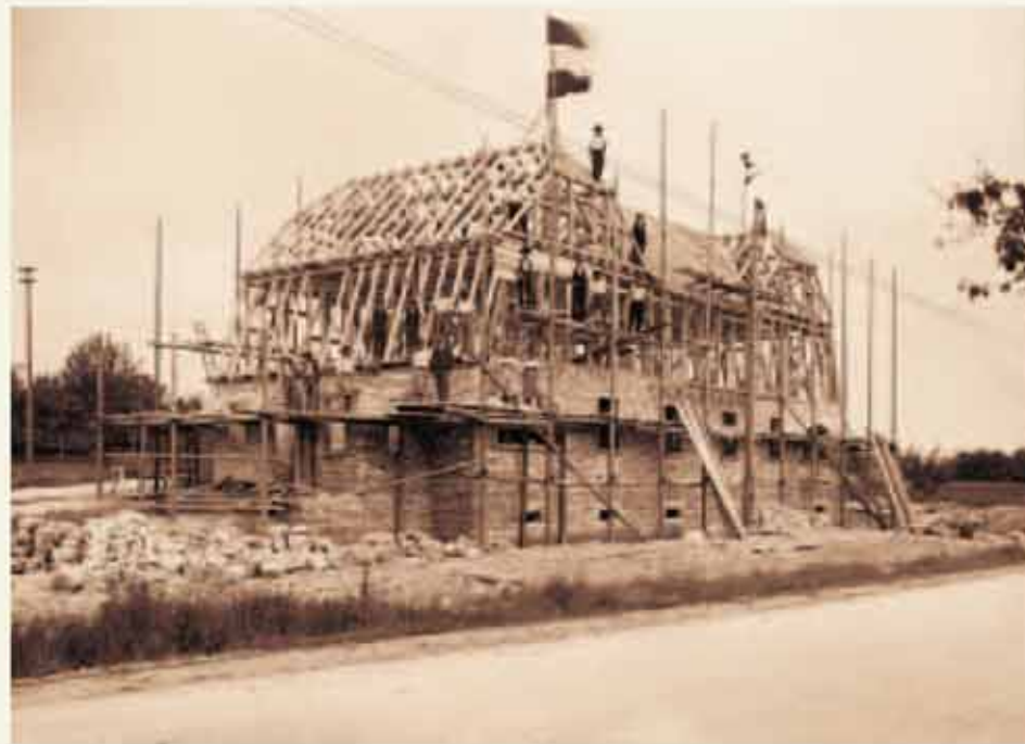
1903 - auf dem etwa 100 ha großen Gelände wird mit Bauarbeiten begonnen - ein Gebäude kostet rd. 110 Tsd. Reichsmark
