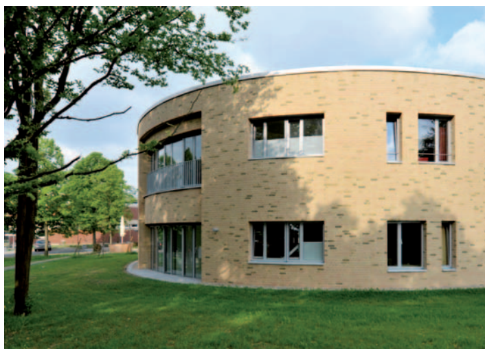
Der Neubau des Gerontopsychiatrisches Zentrums
